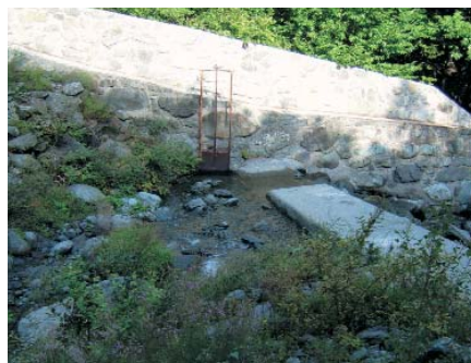
Sistemazione briglia per la presa dell'acqua ad uso irriguo del ru plan
